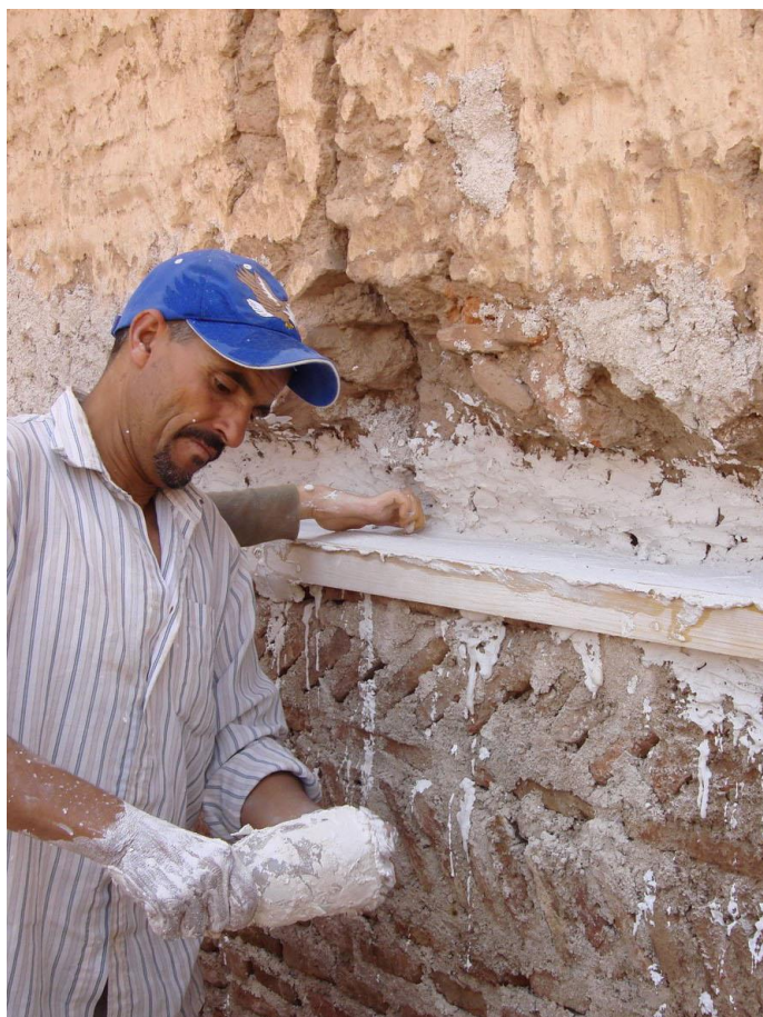
Maçon sur un chantier de restauration © Aurélie Terrier
